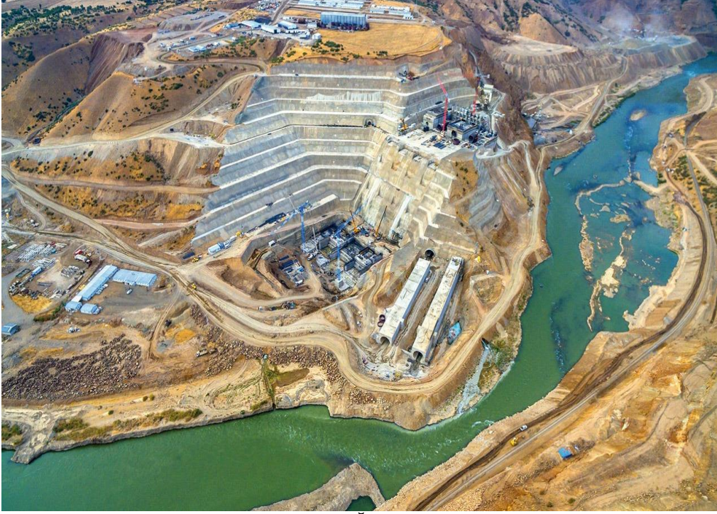
Resim B.3- AŞAĞI Kaleköy Barajı (HES)
