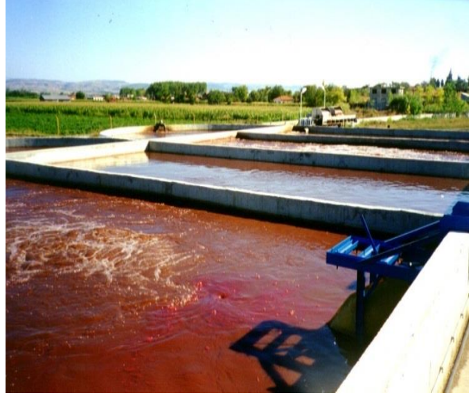
Resim 4- Salça Fabrikası Arıtma Tesisii
