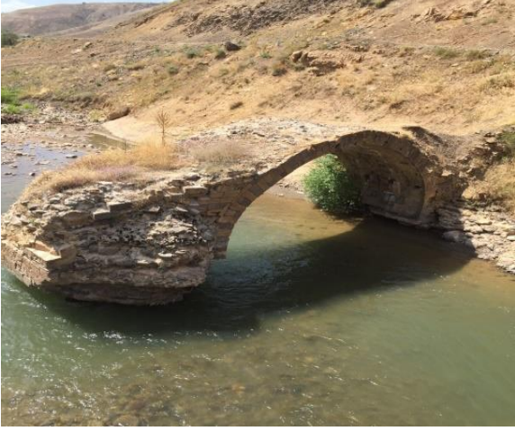
Karlıova Osmanlı Köprüsü
