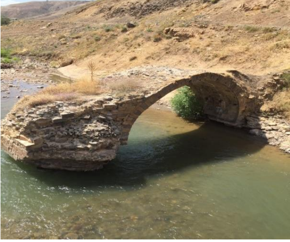
Karlıova Osmanlı Köprüsü
