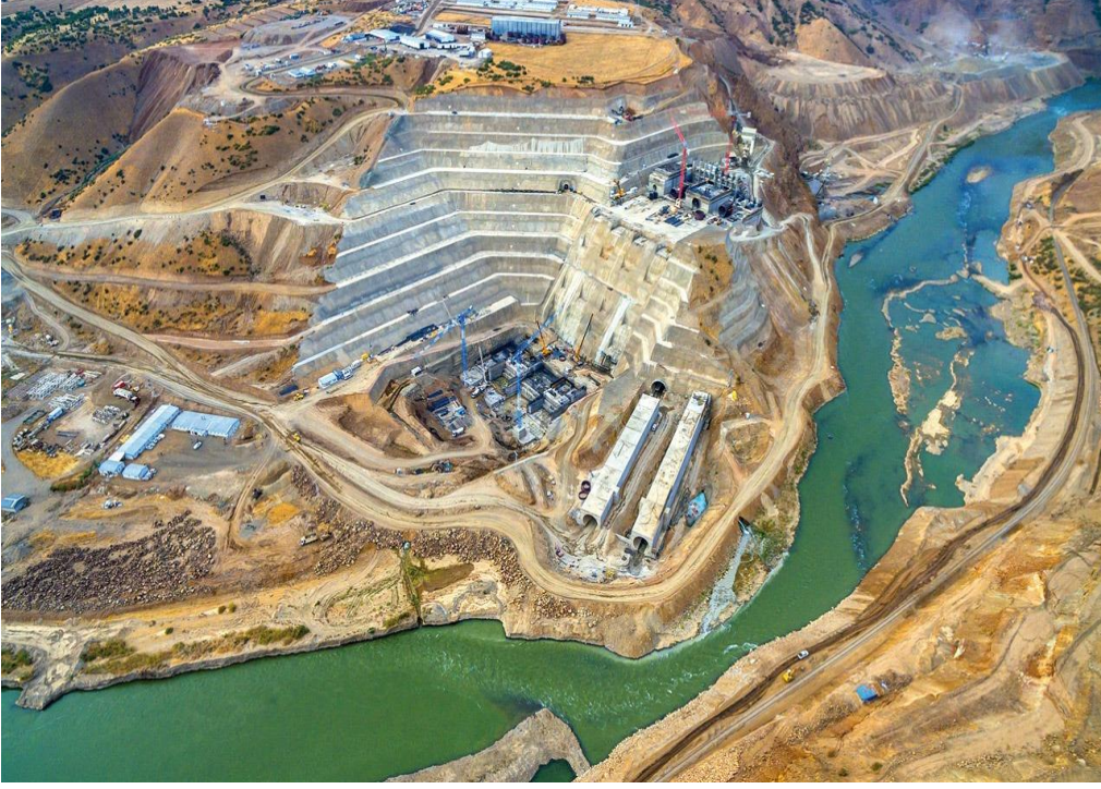
Resim B.4 - Aşağı Kaleköy Barajı
