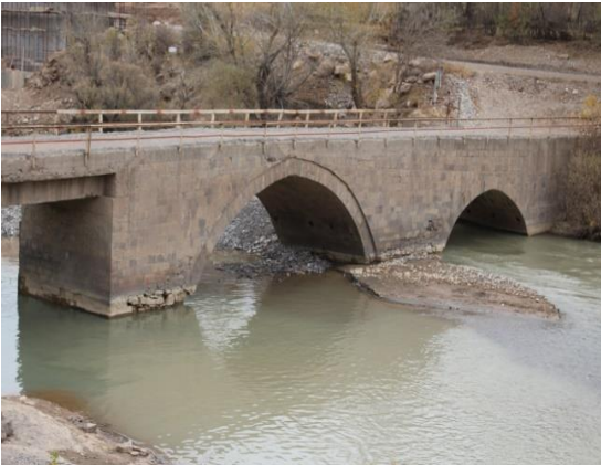
Kığı Selenk Köprüsü
