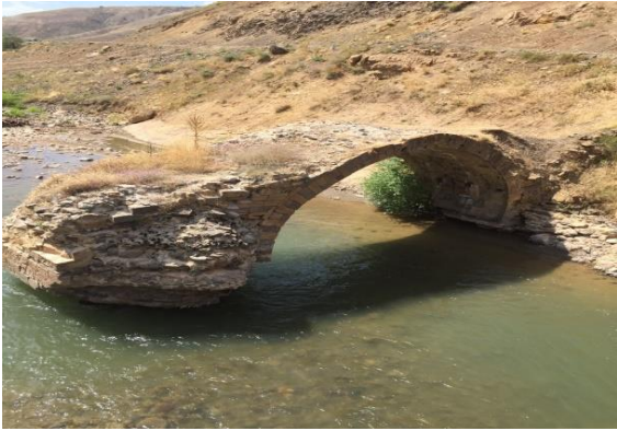
Karlıova Osmanlı Köprüsü
