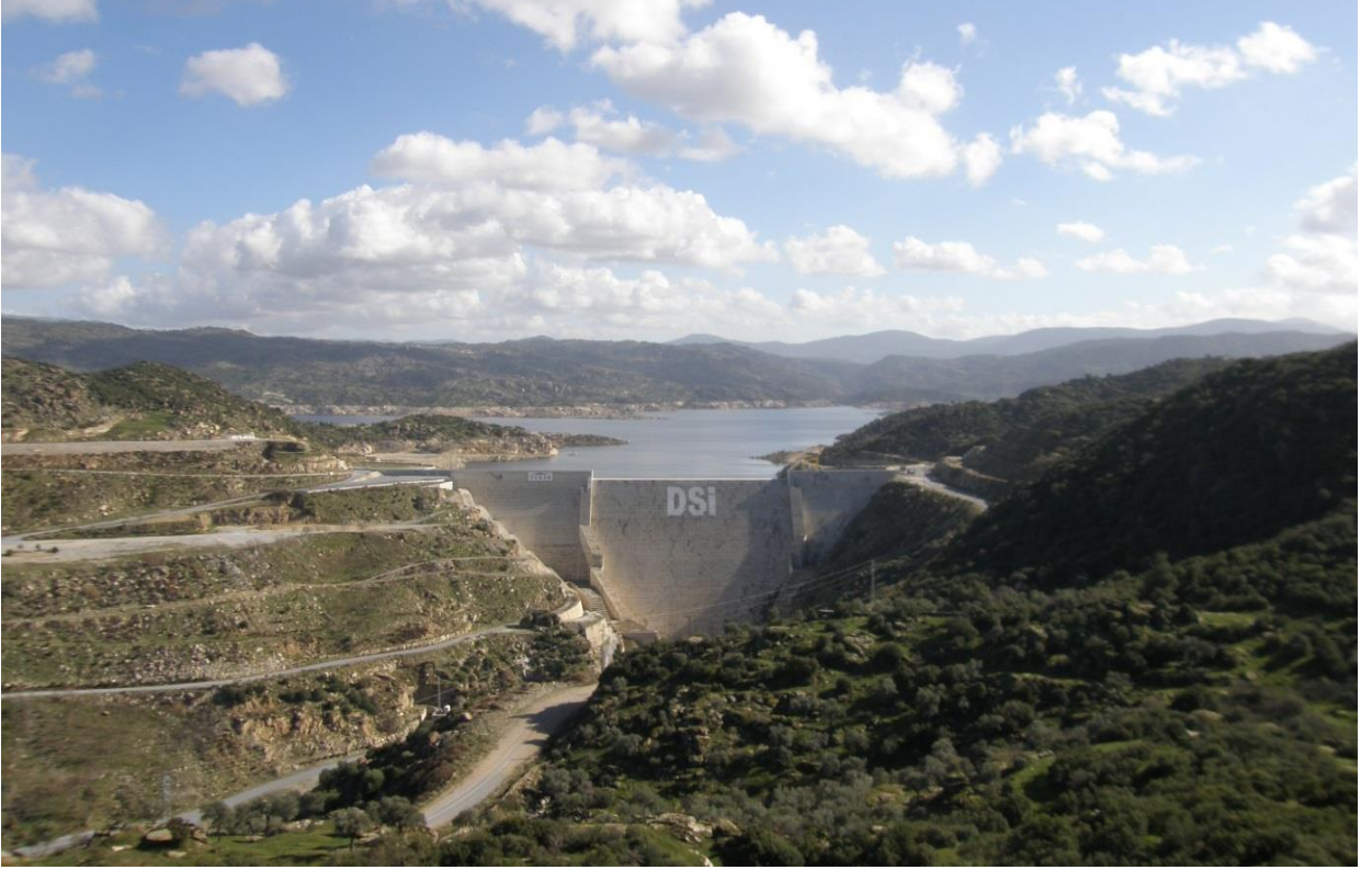
Resim D. 9 Çine Barajı
