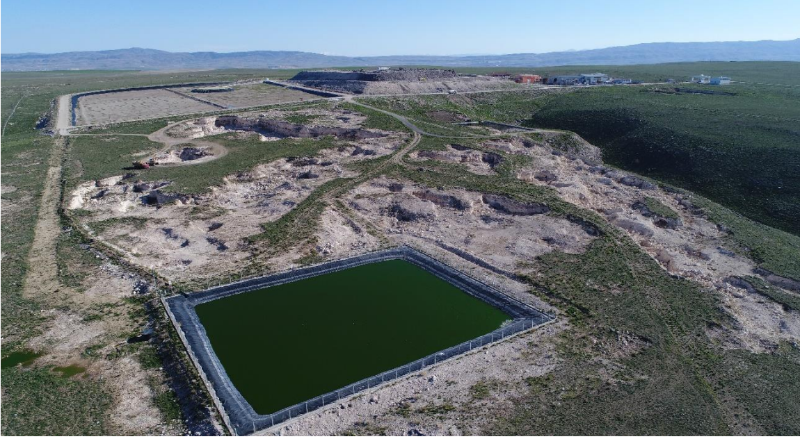
Resim 1 Atıksu Arıtma Tesisine yaptırılan sızıntı suyu dengeleme havuzu
