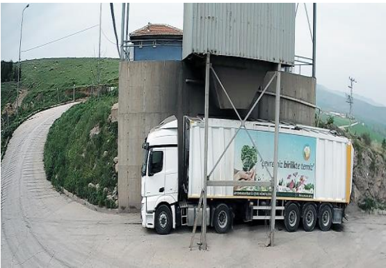
Sandıklı Katı Atık Aktarma İstasyonu
