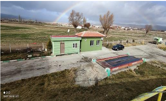
Şuhut Katı Atık Aktarma İstasyonu
