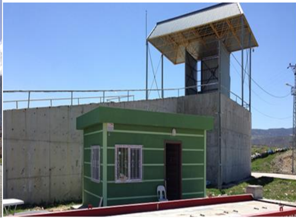
Sinanpaşa Katı Atık Aktarma İstasyonu
