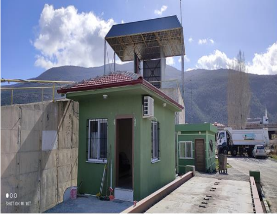
Çay Katı Atık Aktarma İstasyonu
