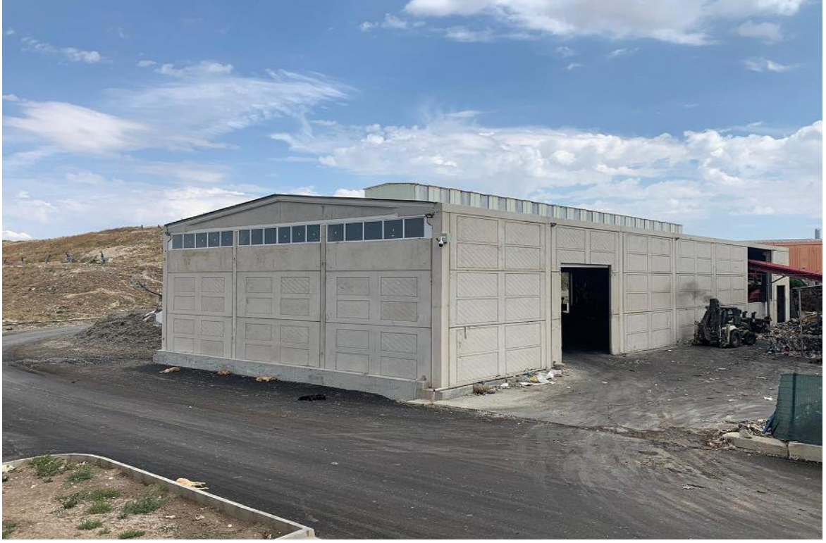
Resim 6 Atıktan Türetilmiş Yakıt Tesisi
