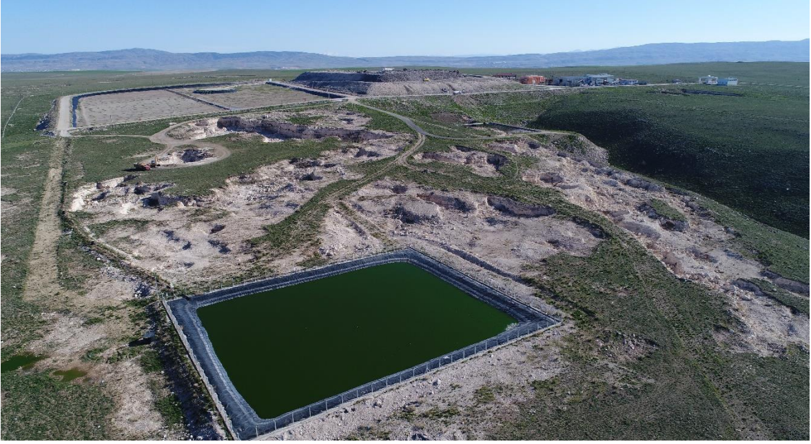
Sızıntı Suyu Havuzu
