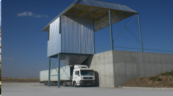
Emirdağ Katı Atık Aktarma İstasyonu
