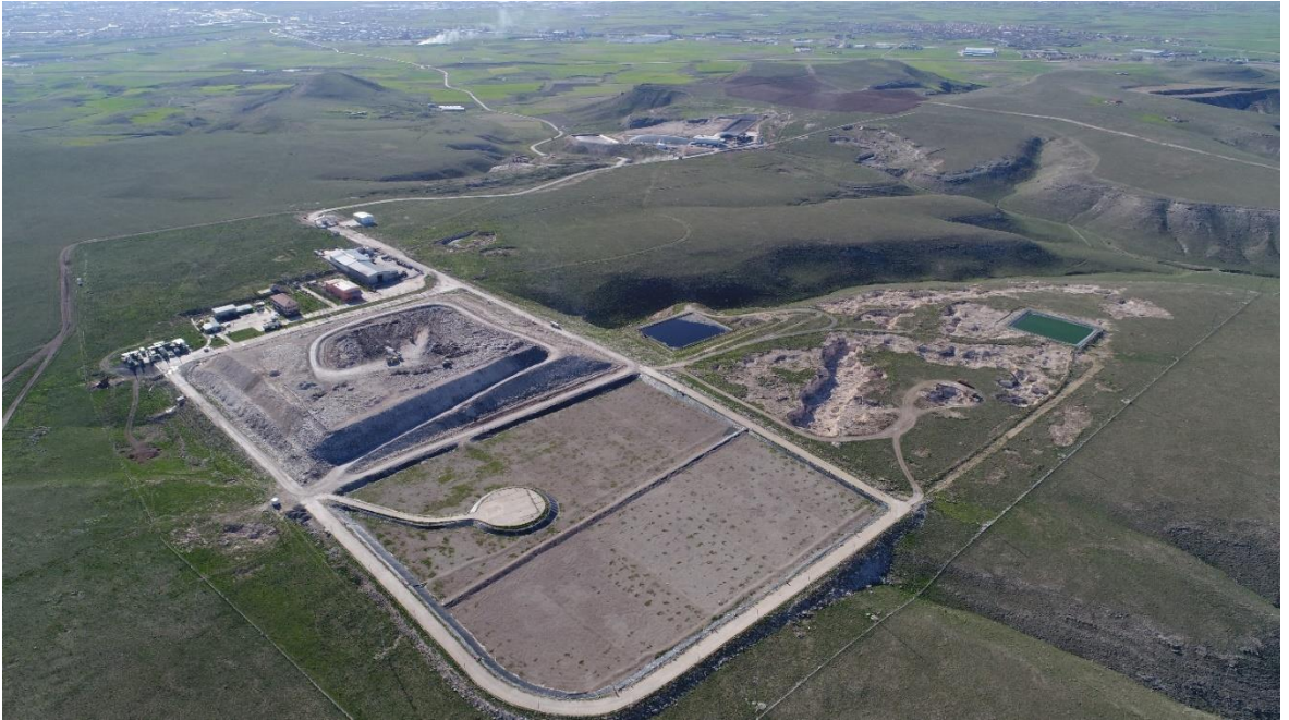
Resim C.3. Katı atık düzenli depolama ve bertaraf tesisi genel görünümü
