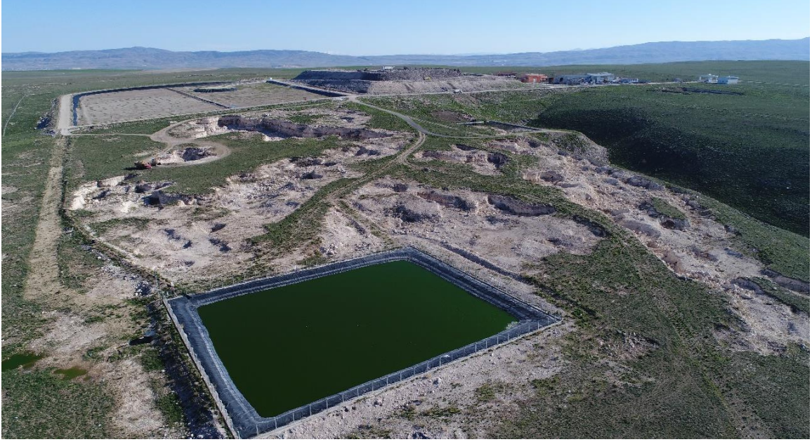
Resim B.2 - Sızıntı suyu dengeleme havuzu
