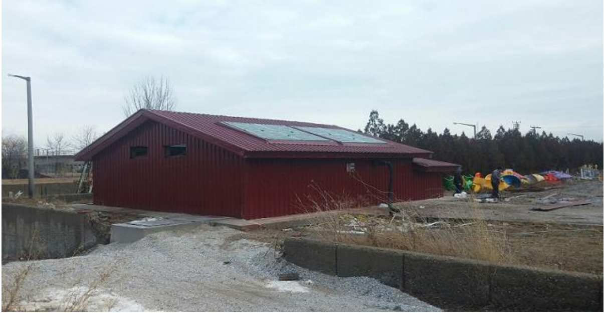
Resim B. 3 - Sızıntı suyu dengeleme havuzu
