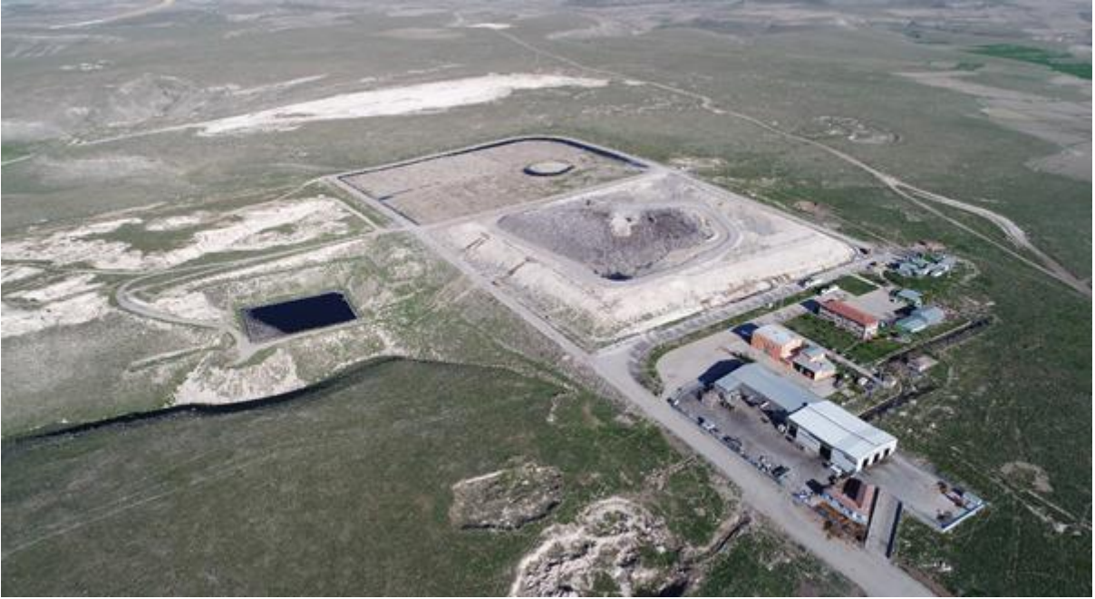
Resim C.6 - Katı atık düzenli depolama lotu genel görünüm
