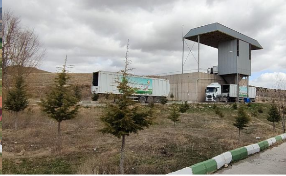
Bolvadin Katı Atık Aktarma İstasyonu
