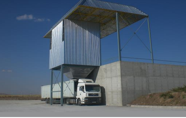
Emirdağ Katı Atık Aktarma İstasyonu
