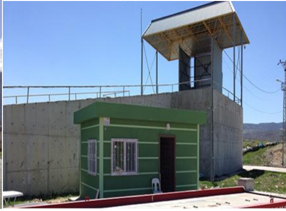
Sinanpaşa Katı Atık Aktarma İstasyonu
