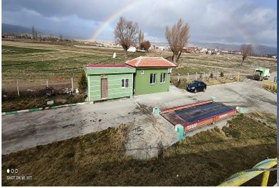
Şuhut Katı Atık Aktarma İstasyonu
