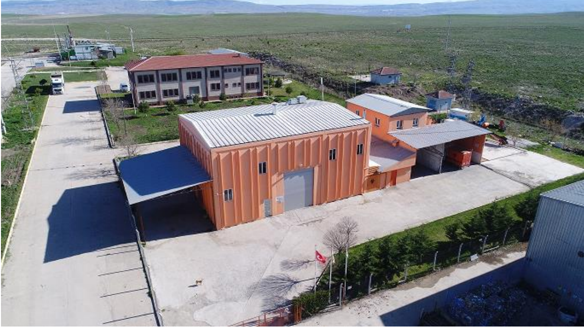
Tıbbi Atık Sterilizasyon Tesisi
