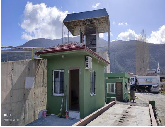
Çay Katı Atık Aktarma İstasyonu
