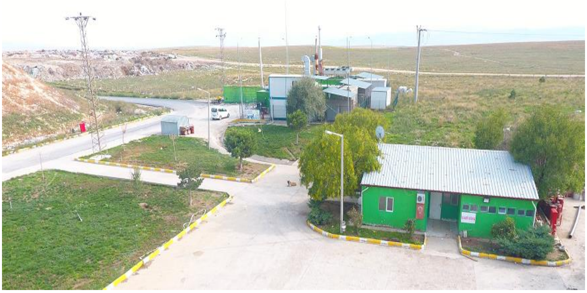
Düzenli Depolama Lotunda Oluşan Biyogazdan Elektrik Enerjisi Üretim Tesisi
