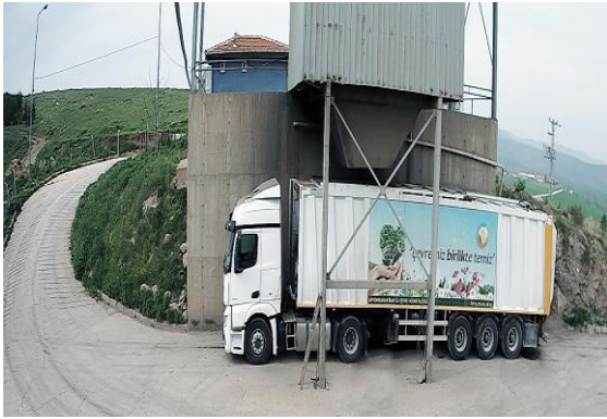
Sandıklı Katı Atık Aktarma İstasyonu
