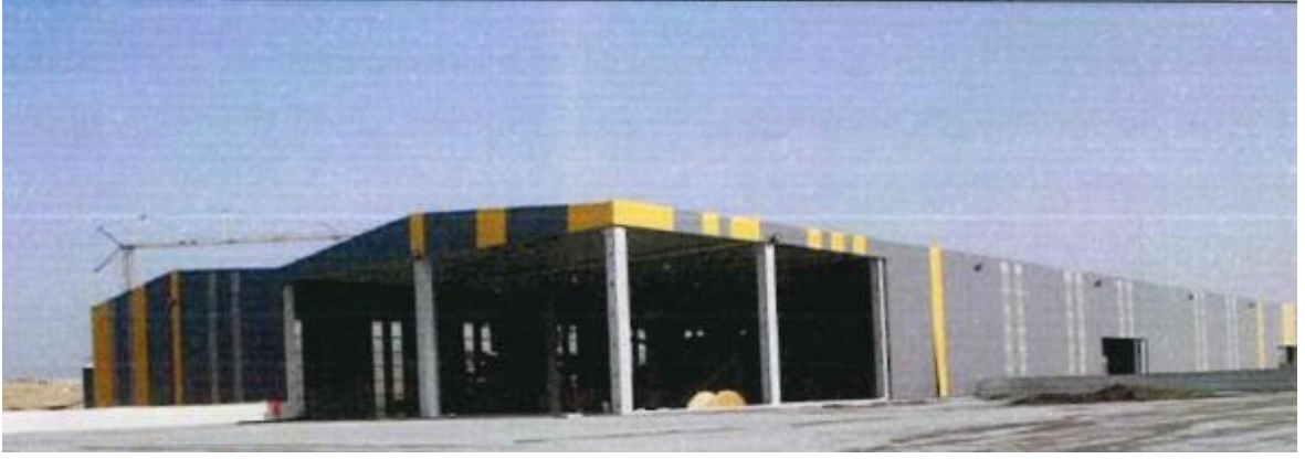
Resim 3 -Mekanik Ayırma Tesisi (Dış Görünüş)
