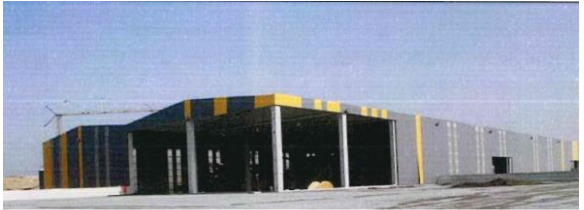
Resim 4-Mekanik Ayırma Tesisi (Dış Görünüş)
