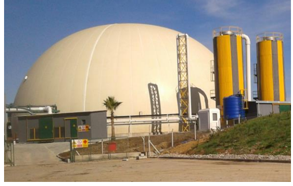
Resim 2-Gaz Depolama Balonu
