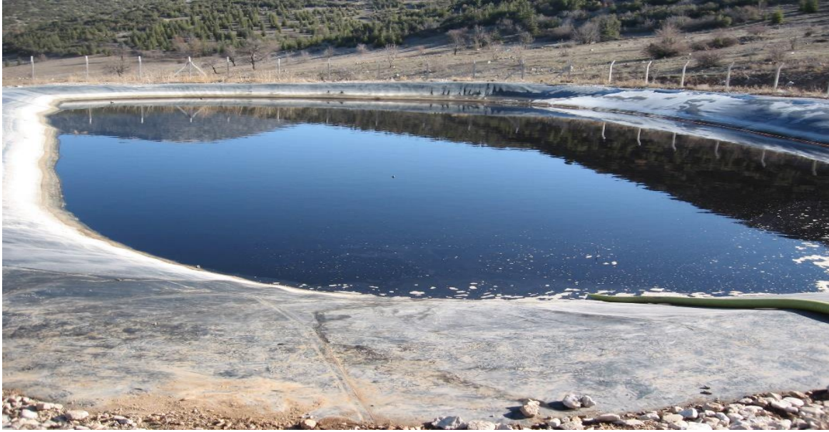
Resim 1- Sızıntı suyu toplama havuzu
