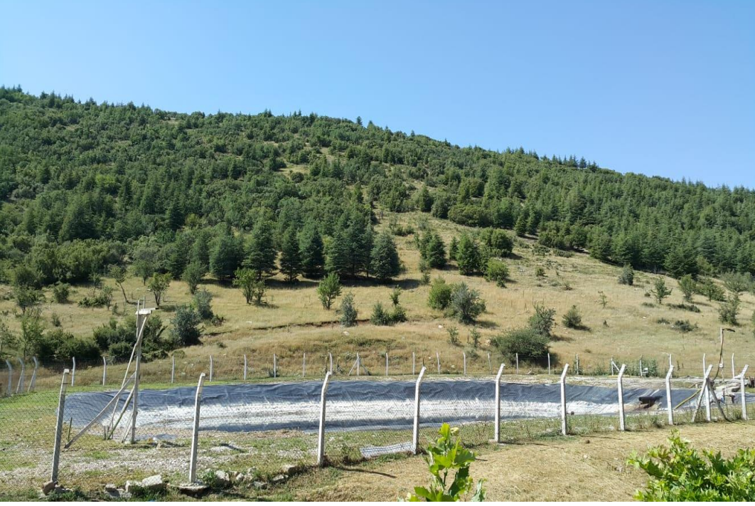
Resim 4 - Göller Bölgesi Belediyeler Birliğine ait Koçtepe Düzenli Katı Atık Depolama Tesisi sızıntı suyu toplama havuzu
