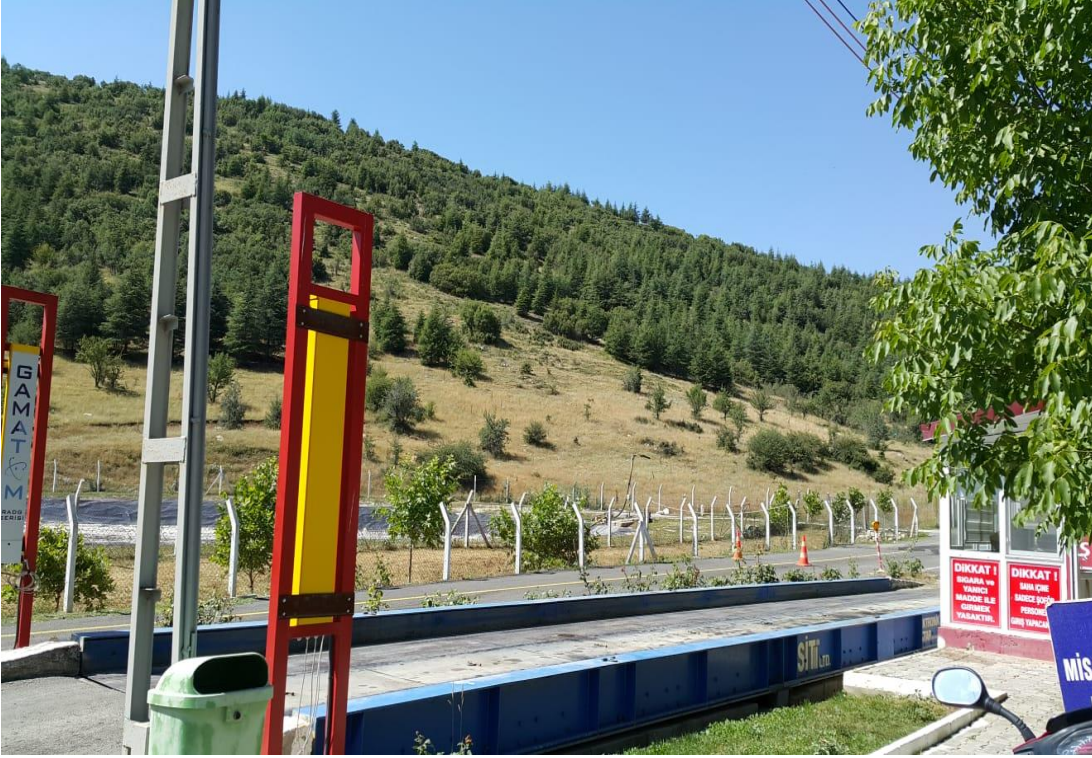
Resim 2 - Göller Bölgesi Belediyeler Birliğine ait Koçtepe Düzenli Katı Atık Depolama Tesisi kantar ünitesi
