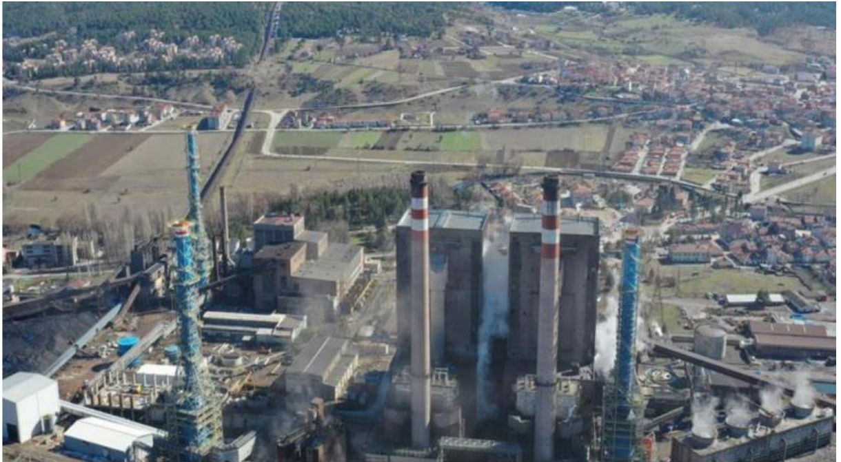
Resim 3- Tunçbilek Termik Santrali
