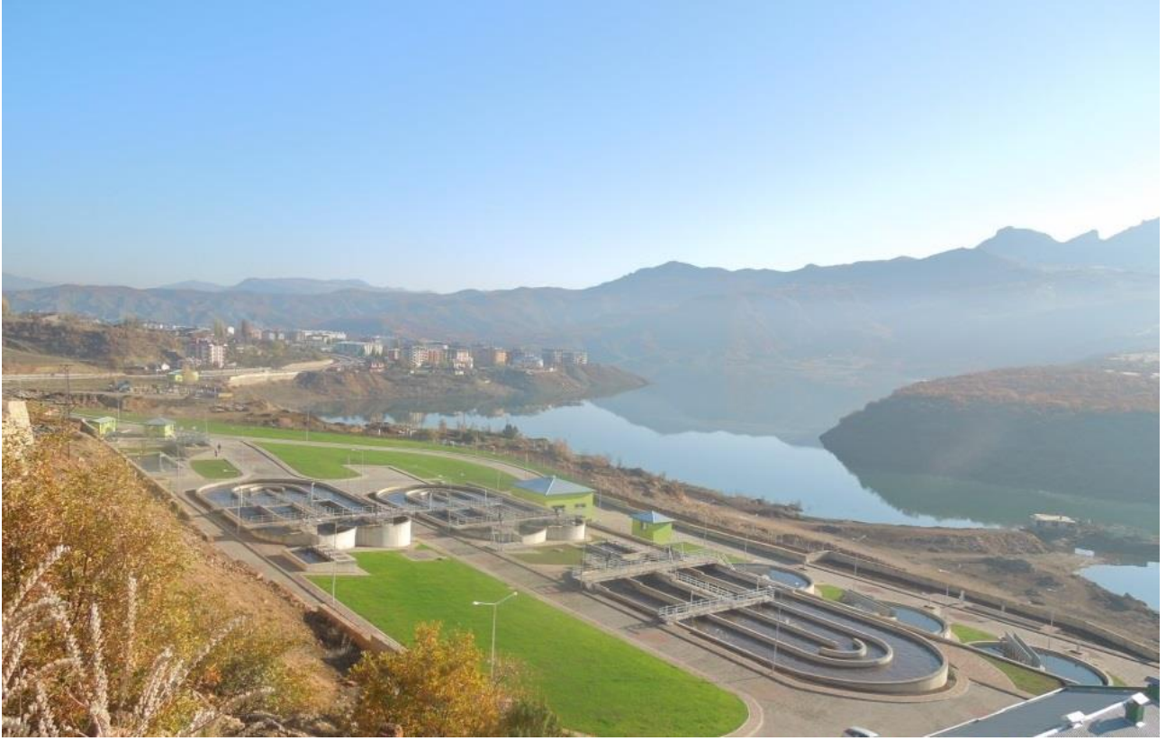
Resim B.1 – Atıksu Arıtma Tesisi Genel Görünüm
