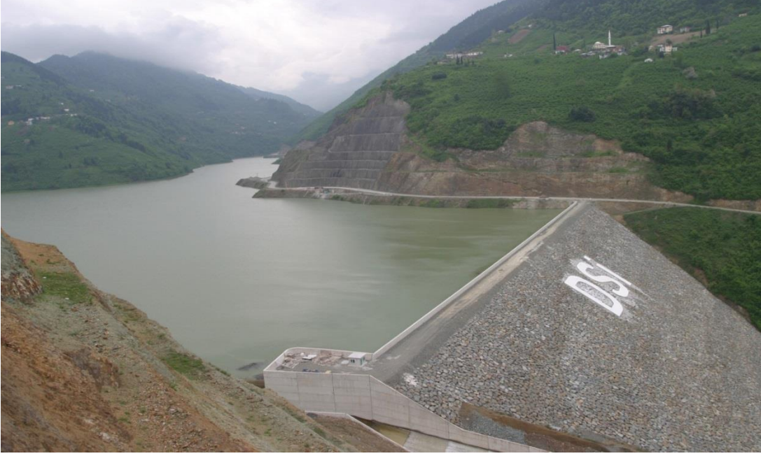
Resim B.1 – Atasu Barajının Genel Görünümü
