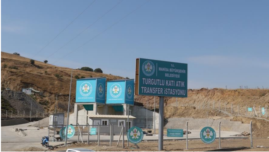
Resim C.2 - Turgutlu İlçesi Katı Atık Transfer İstasyonu
