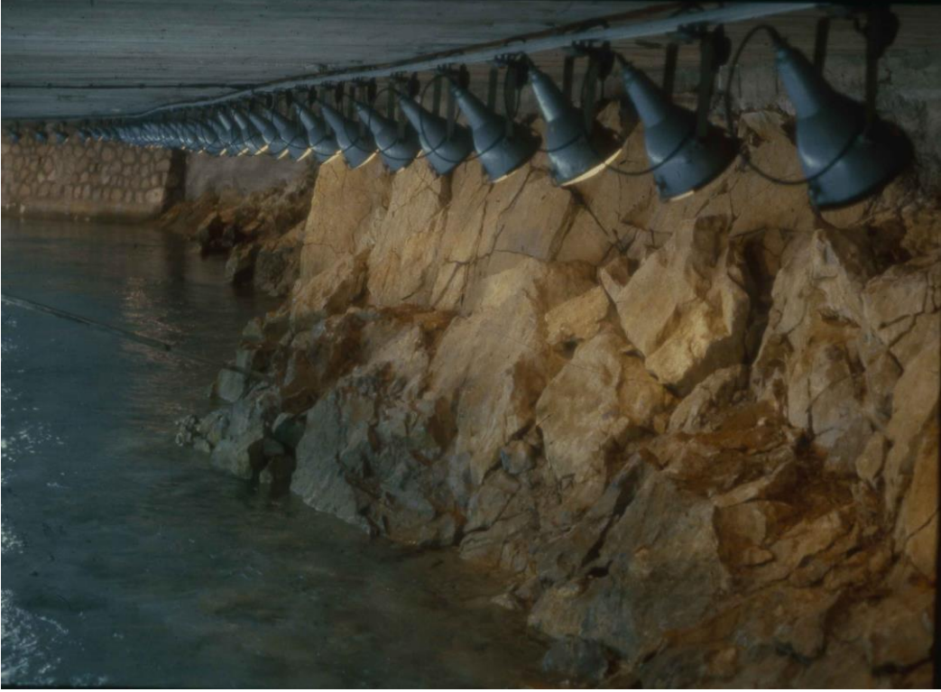
Resim B.2-İçme Suyu Kaynağı Malatya –Kaptaj
