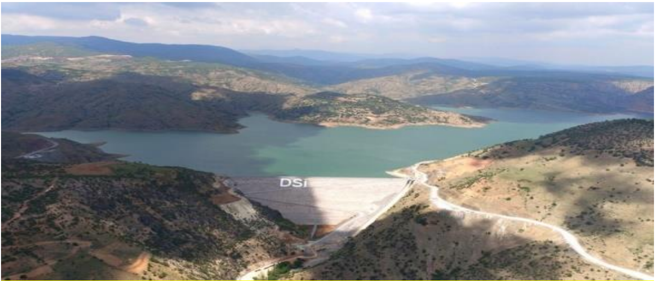
Resim C.4 – Bağbaşı Barajı (KOSKİ, 2021)
