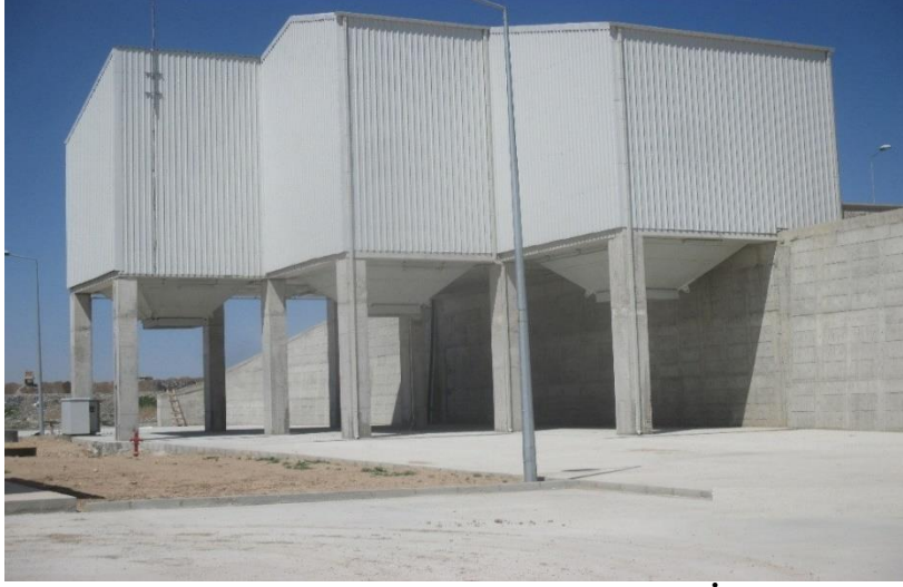
Resim C.6 – Aşım Katı Atık Transfer İstasyonu (Konya Büyükşehir Belediyesi, 2021)
