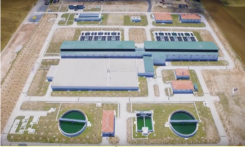
Resim C.1 – Seçme İçme Suyu Arıtma Tesisi (KOSKİ, 2021)
