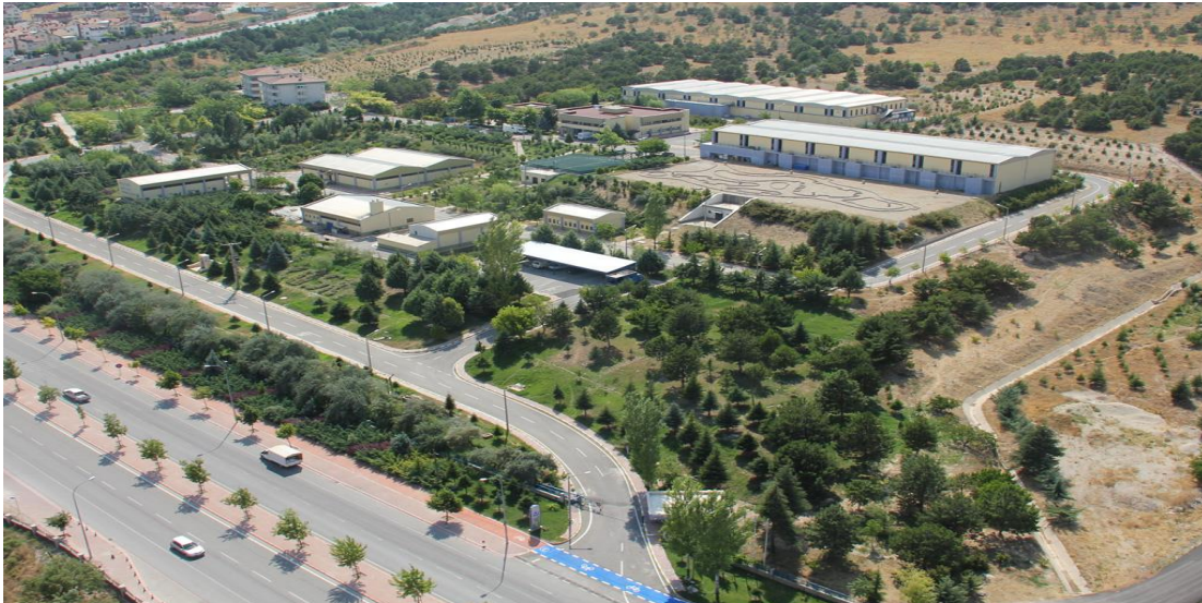
Resim C.2 – Akyokuş İçme Suyu Arıtma Tesisi (KOSKİ, 2021)
