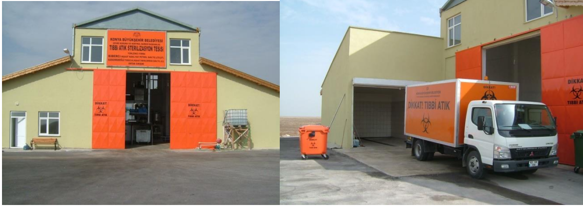
Resim C.29 – Tıbbi Atık Sterilizasyon Tesisi (Konya Büyükşehir Belediyesi, 2021)
