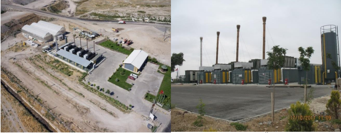
Resim C.13 – Aslım Metan Gazından Elektrik Enerjisi Üretim Tesisi (Konya Büyükşehir Belediyesi, 2021)
