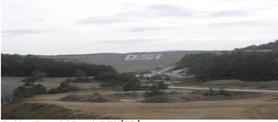
Resim B.5 - Baklan Boğaziçi Barajı DENİZLİ
