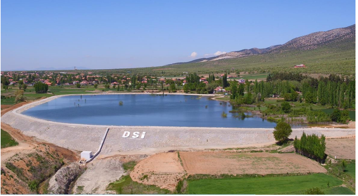
Güney Eziler Göleti: Denizli ili Güney ilçesine bağlı Eziler Mahallesi sınırları içerisinde Kadıkuyu deresi üzerindedir. Proje kapsamında 420 da arazide sulama yapılmaktadır.
