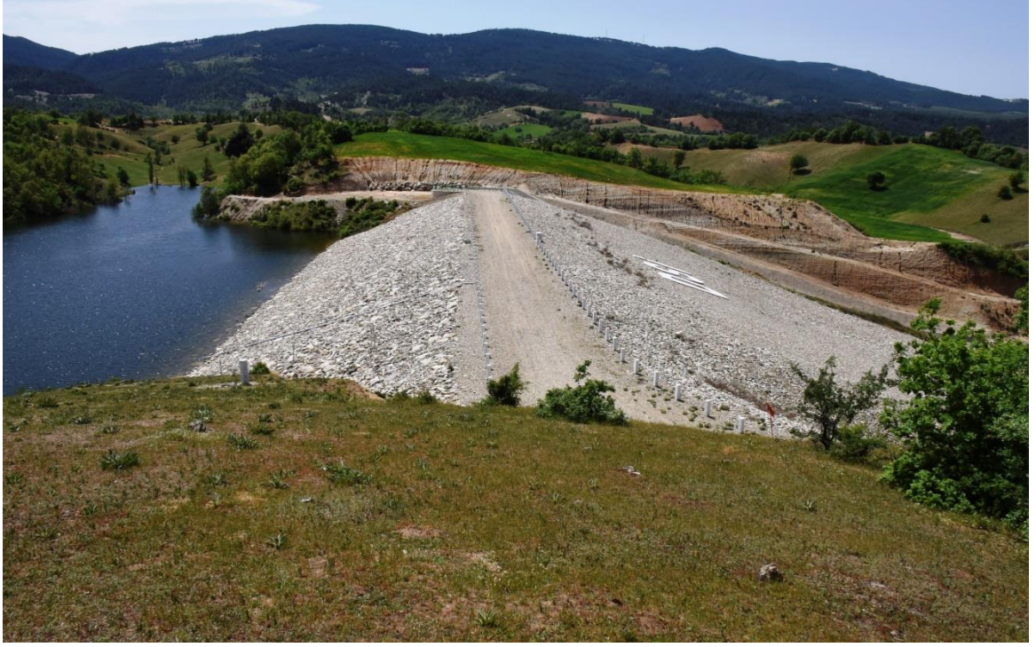
Buldan Dımbazlar Göleti: Denizli ili Buldan ilçesine bağlı Dımbazlar Mahallesi sınırları içerisinde Kırcaoluk deresi üzerindedir. Proje kapsamında 810 da arazide sulama yapılmaktadır.
