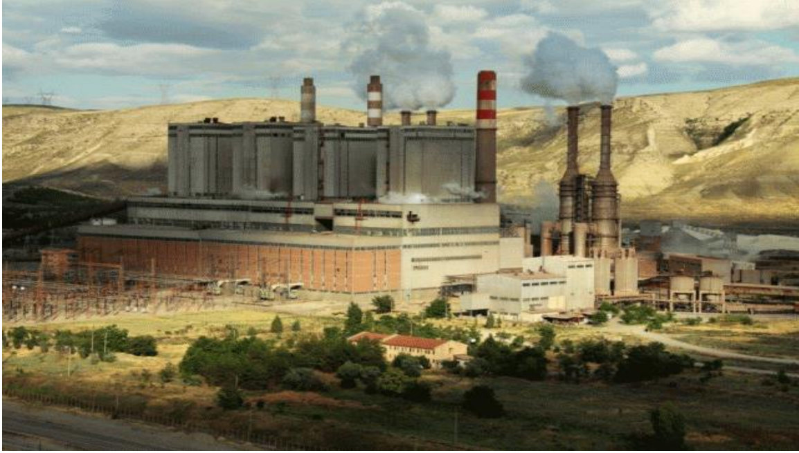
Resim C.1 – Çayırhan Termik Santrali (Ankara Çevre ve Şehircilik İl Müdürlüğü, 2021)
