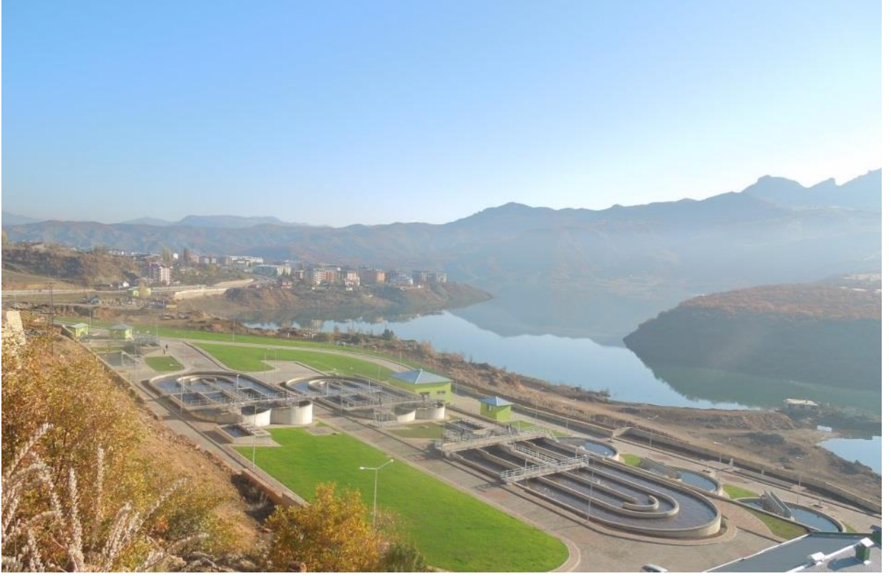
Resim B.1 - Atıksu Arıtma Tesisi genel görünüm.
