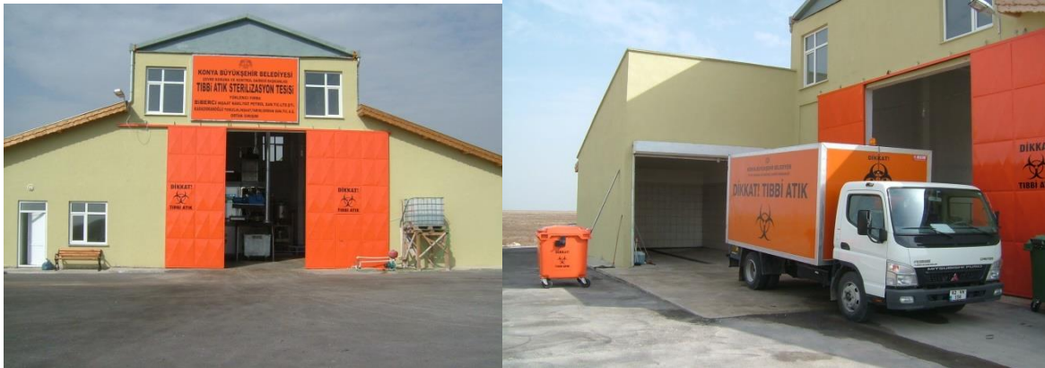
Resim C.28 – Tıbbi Atık Sterilizasyon Tesisi (Konya Büyükşehir Belediyesi, 2020)
