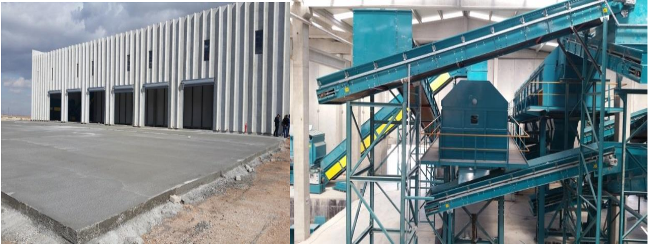
Resim C.7 – Eysel Katı Atık Ayrıştırma Tesisi (Konya Büyükşehir Belediyesi, 2020)
