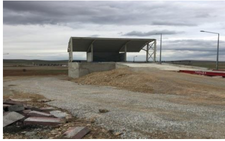
Resim C.13 – Ladik Transfer İstasyonu (Konya Büyükşehir Belediyesi, 2020)
