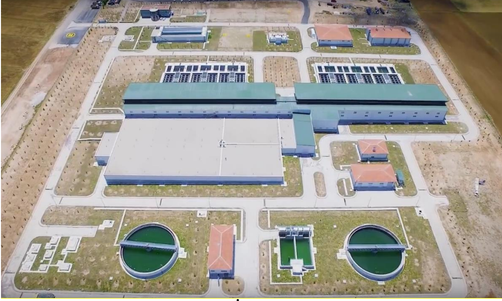
Resim C.1 – Seçme İçme Suyu Arıtma Tesisi (KOSKİ, 2020)
