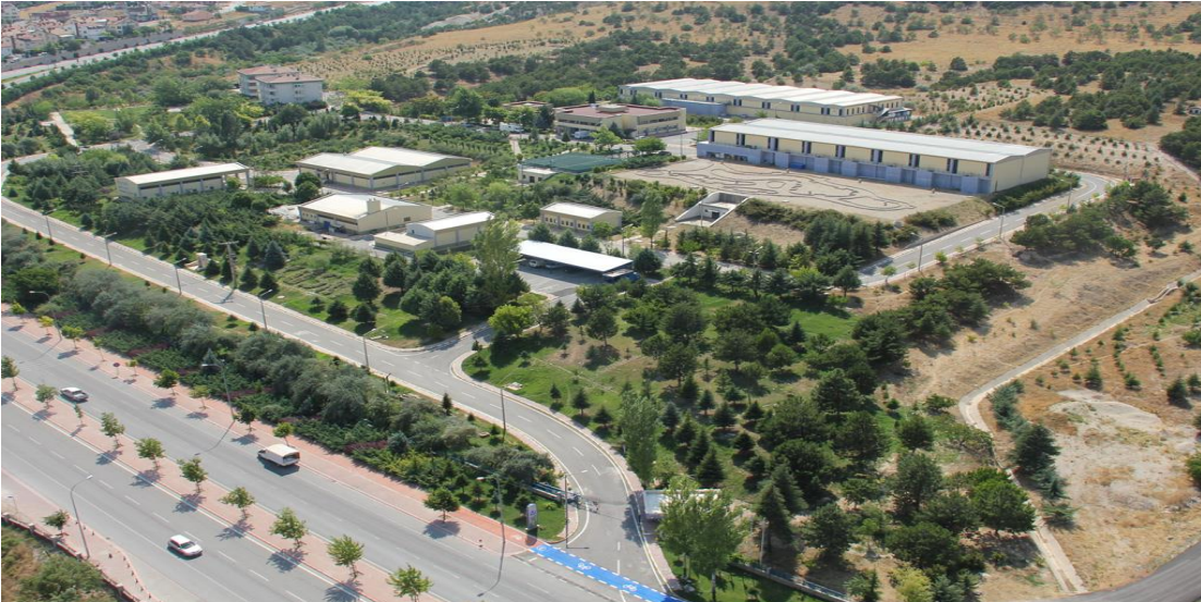
Resim C.2 – Akyokuş İçme Suyu Arıtma Tesisi (KOSKİ, 2020)
