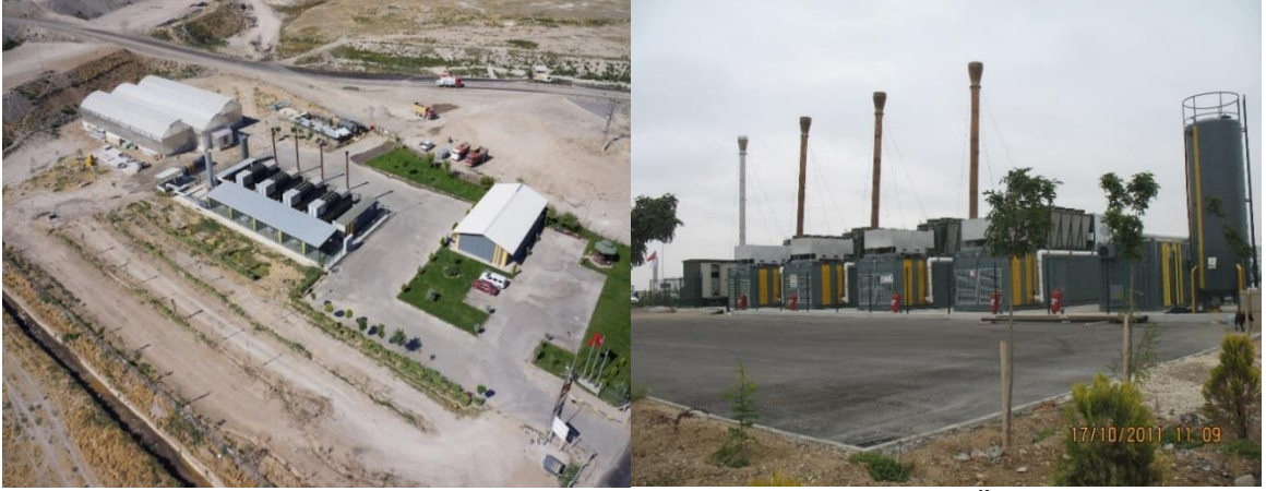
Resim C.14 – Aslım Metan Gazından Elektrik Enerjisi Üretim Tesisi (Konya Büyükşehir Belediyesi, 2020)
