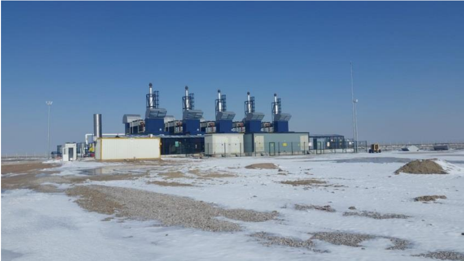
Resim C.16 – Kaşınhanı Metan Gazından Elektrik Enerjisi Üretim Tesisi (Konya Büyükşehir Belediyesi, 2020)
