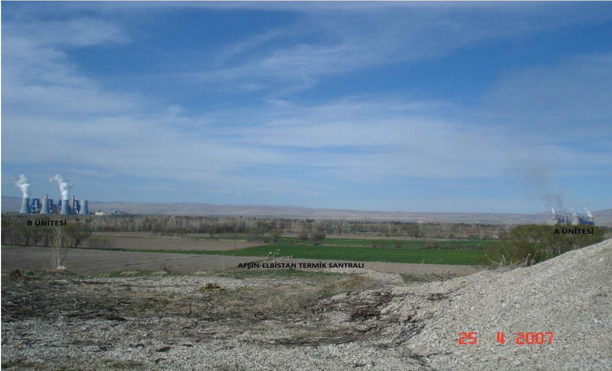
Şekil C.22 – Afşin-Elbistan Termik Santrali (ÇŞİM, 2018)
