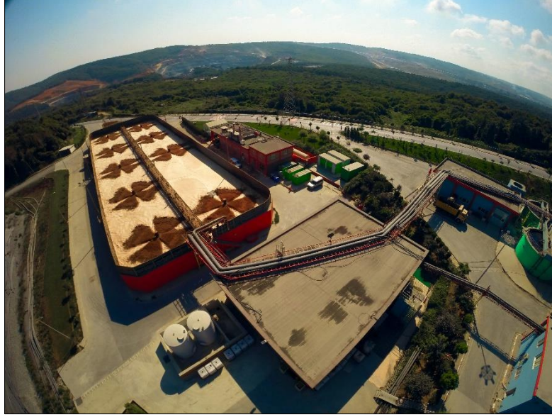
Resim C.3 – Odayeri Sızıntı Suyu Arıtma Tesisi (İBB, 2020)
