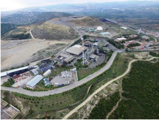
Solaklar Mevkii Katı Atık Bertaraf Tesis
