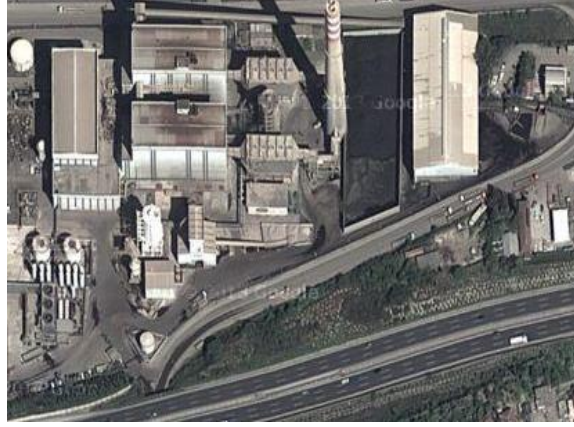
Şekil C.27 - Çolakoğlu Termik Santrali (Kocaeli ÇŞİLM, 2017)
