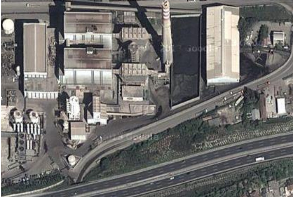
Şekil C.3 – Kocaeli ilinde Bulunan Termik Santrallerin Yeri( Çolakoğlu Metalürji A.Ş.) (Kocaeli Çevre ve Şehircilik İl Müdürlüğü, 2016)
