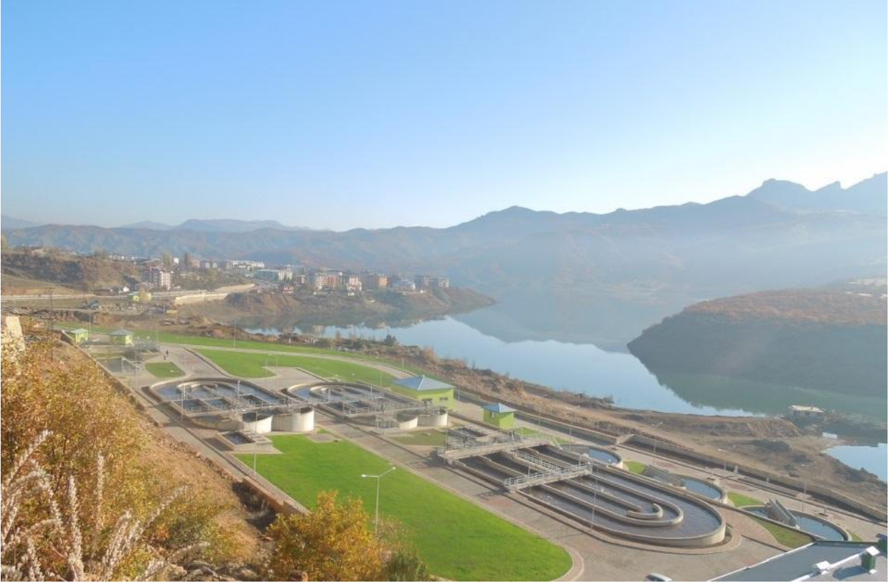
Atıksu Arıtma Tesisi genel görünüm.
