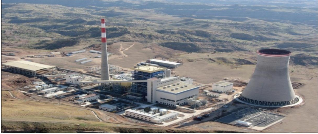
Resim-2– Silopi Termik Santrali (Silopi Elektrik Üretim A.Ş, 2013)
