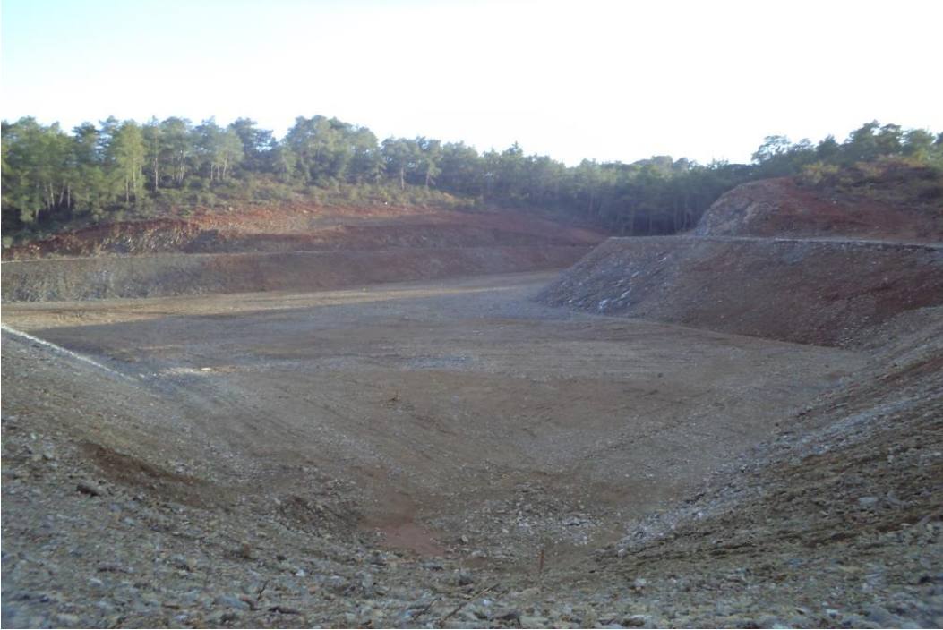
Fotoğraf; 2013 yılı Ortaca katı atık düzenli depolama tesisi 2 etap inşaatı (devam ediyor)
