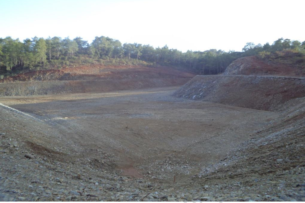
Fotoğraf; 2012 yılı Ortaca katı atık düzenli depolama tesisi 2 etap inşaatı (devam ediyor)
