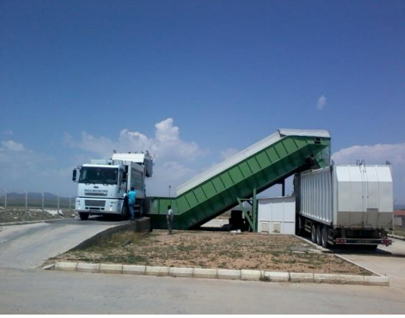
Kulu Transfer İstasyonu
