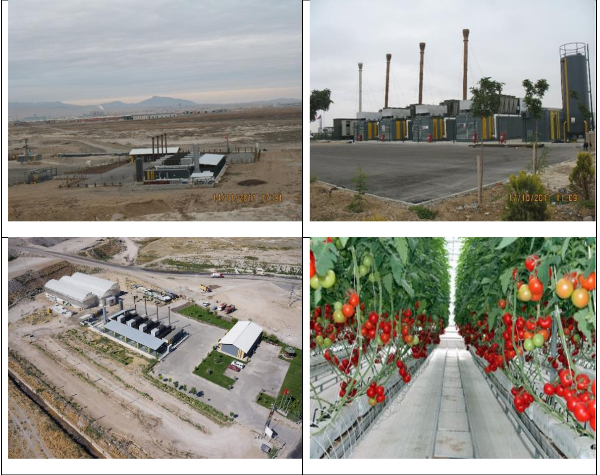
Resimler: Metan Gazından Elektrik Enerjisi Üretim Tesisi ve Sera.
