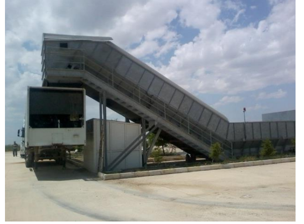
Altınekin Transfer İstasyonu
