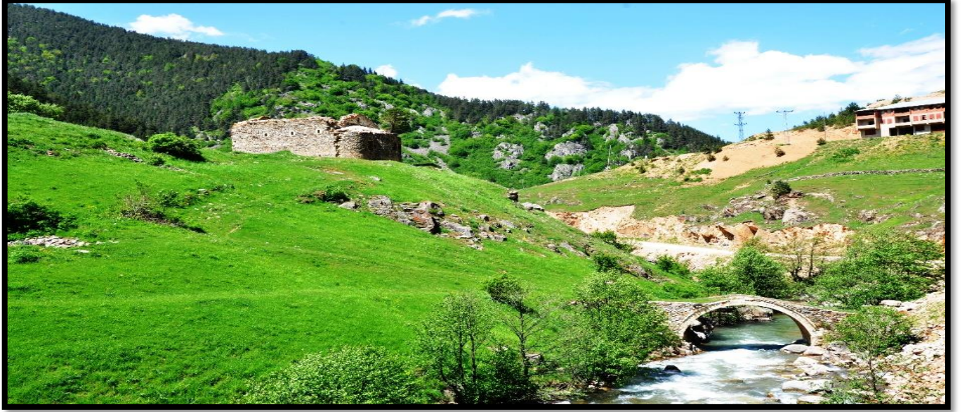
Resim D.2 Çakrak Köyü Köprü ve Kilisesi (Orman ve Su İşleri Bakanlığı, XII. Bölge Müdürlüğü, Giresun Şube Md.,2017)
