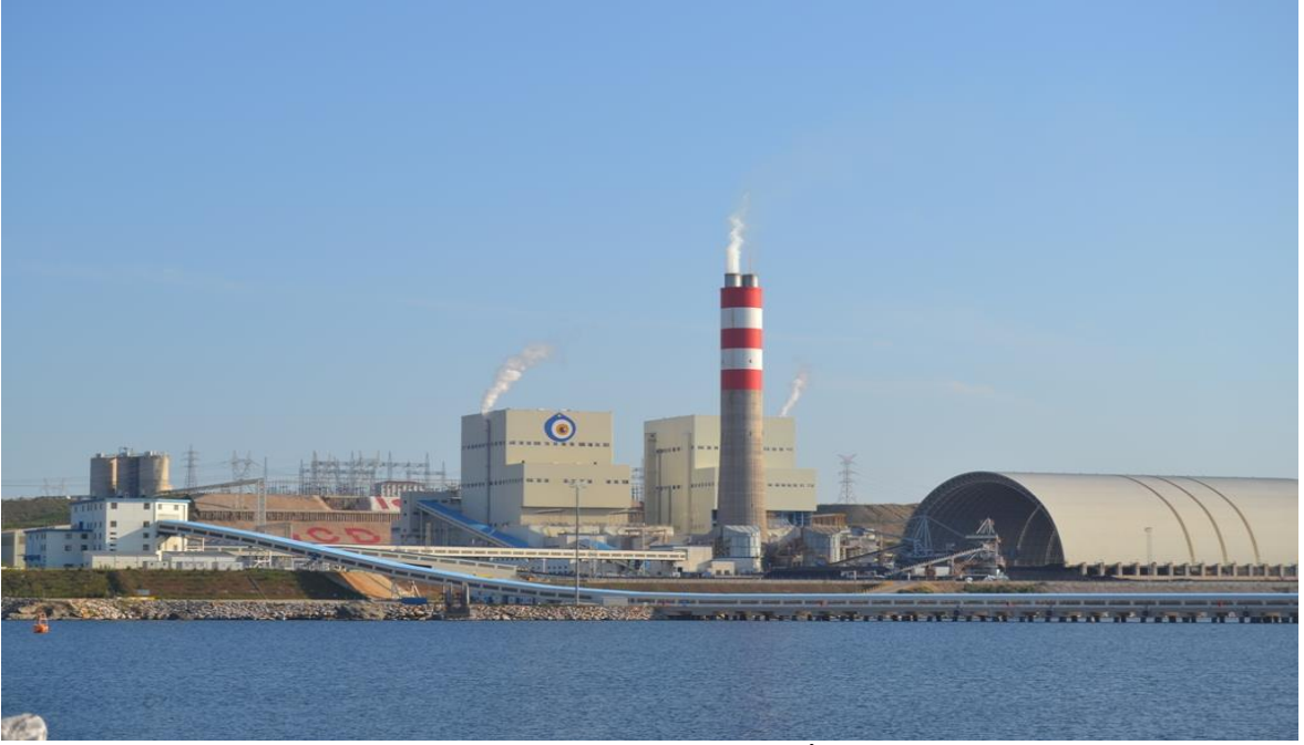
Resim C.2 – Bekirli Termik Santrali (İçdaş A.Ş., 2016)
