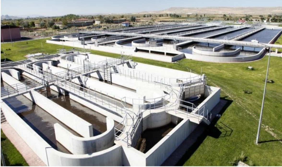
Fotoğraf B.1- Merkez Atıksu Arıtma Tesisi
