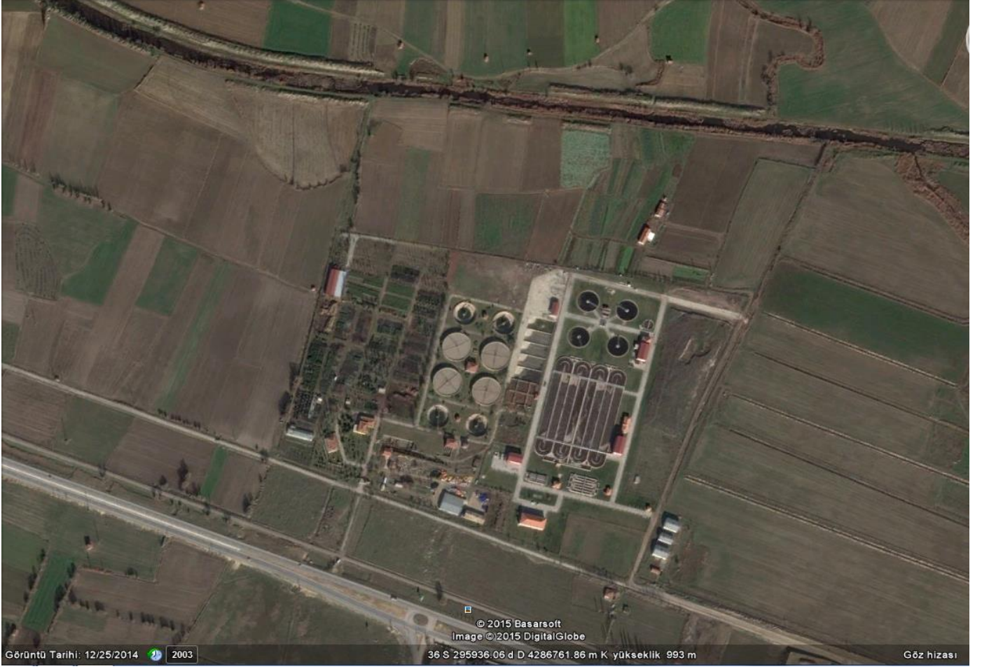
Fotoğraf B.2-Afyonkarahisar Belediyesi Atıksu Arıtma Tesisinin Üstten Görünüşü. (Kaynak: Afyonkarahisar Belediye Başkanlığı)
