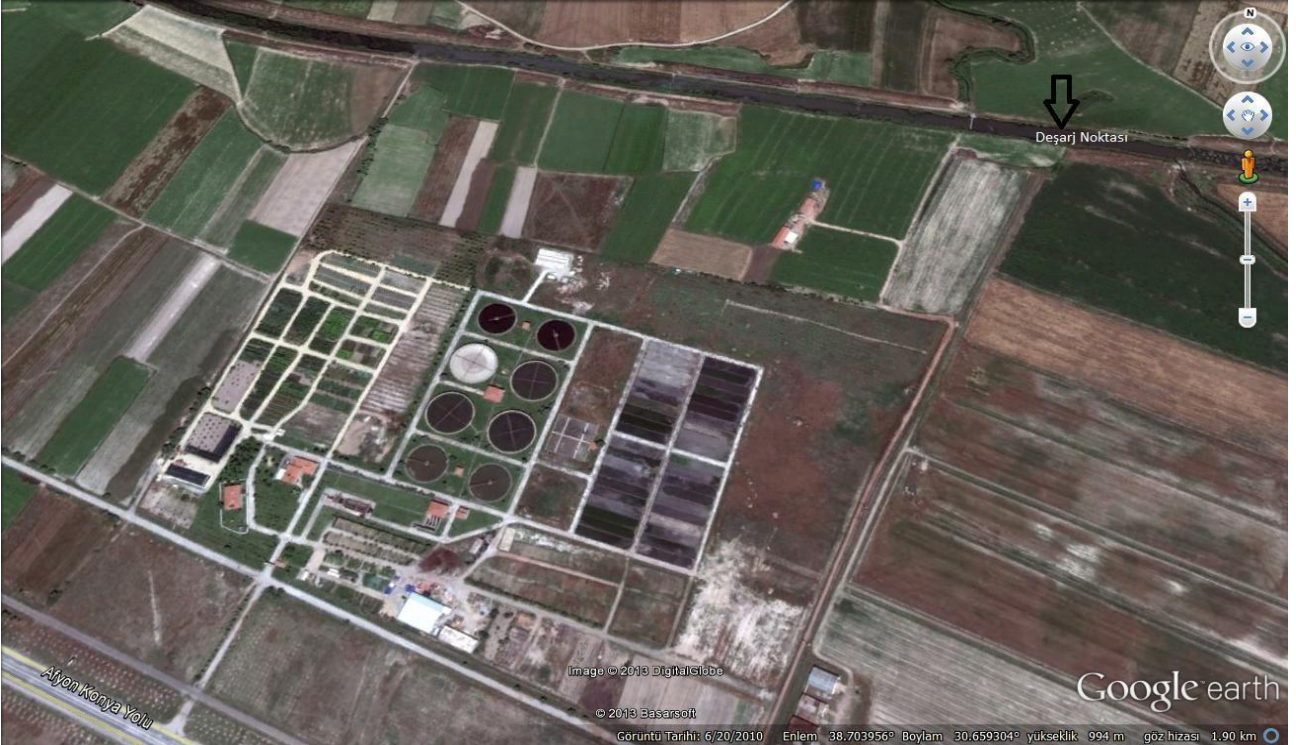
Resim B.2- Afyonkarahisar Atıksu Arıtma Tesisini
