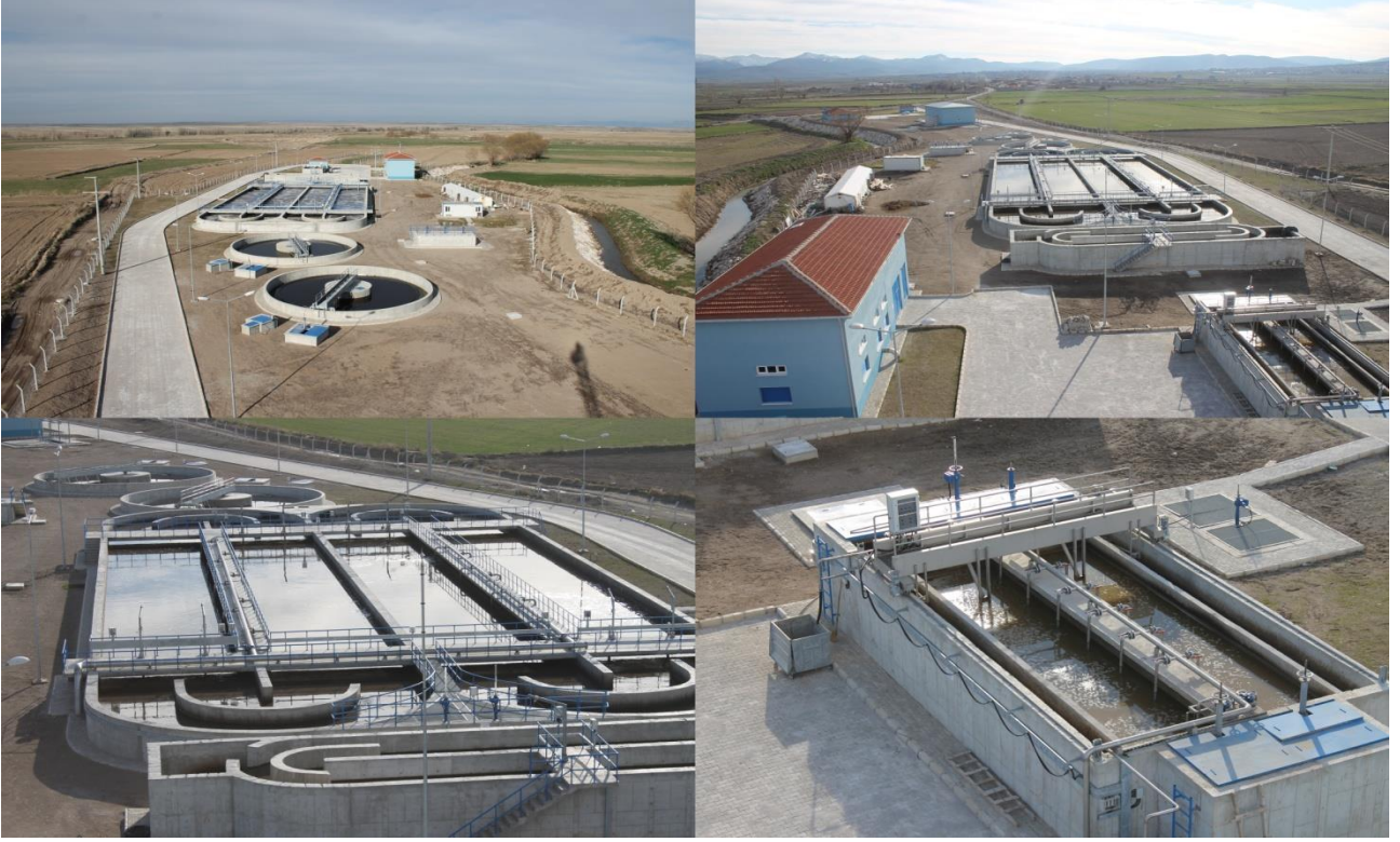
Resim B.1- Emirdağ Atıksu Arıtma Tesisinin Üstten Görünüşü (Emirdağ Belediyesi)
