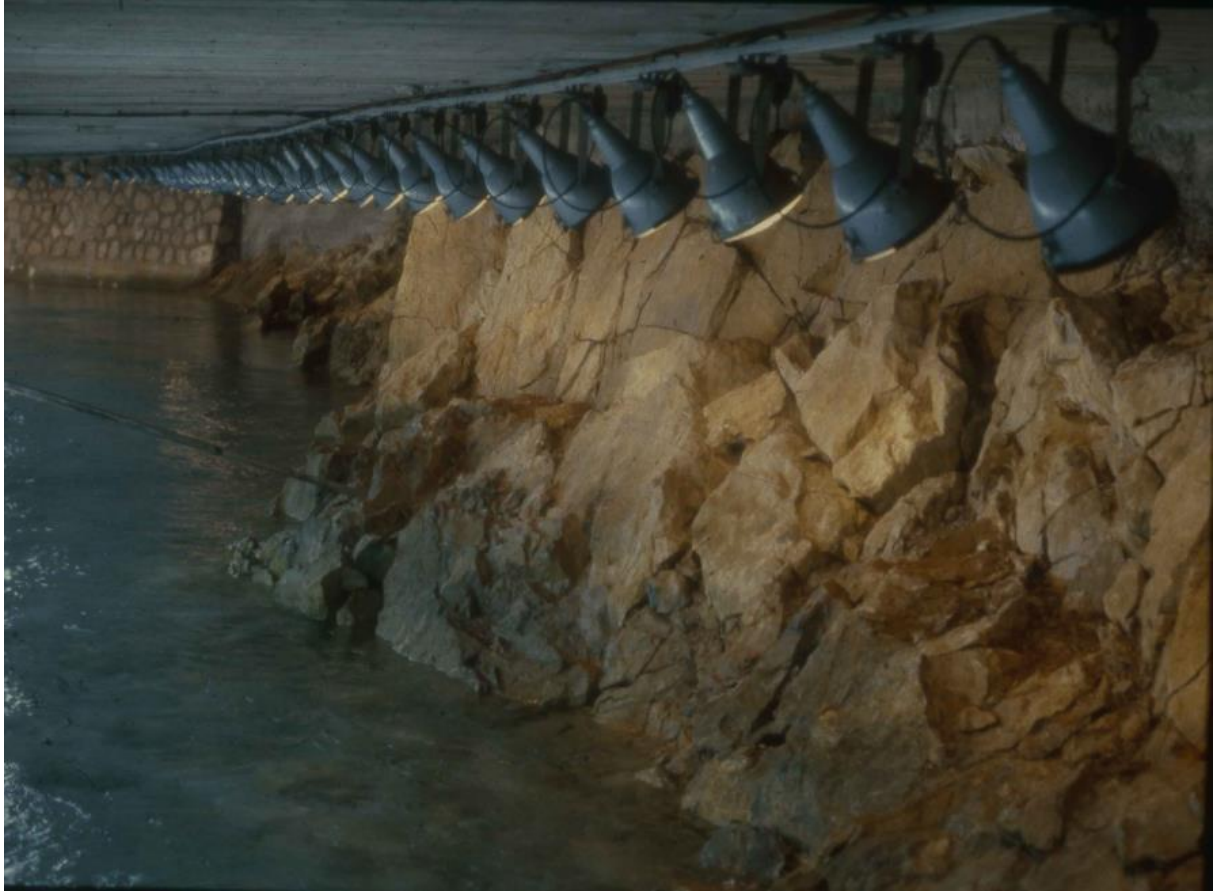
Fotoğraf 33 - İçme suyu kaynağı Malatya – Kaptaj
