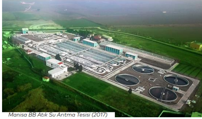
Manisa BB Atık Su Arıtma Tesisi (2017)
