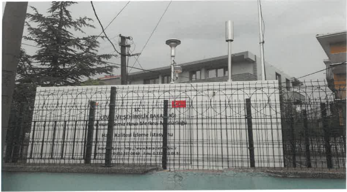
Şekil-10: Çanakkale Biga Hava Kalitesi İzleme İstasyonu
