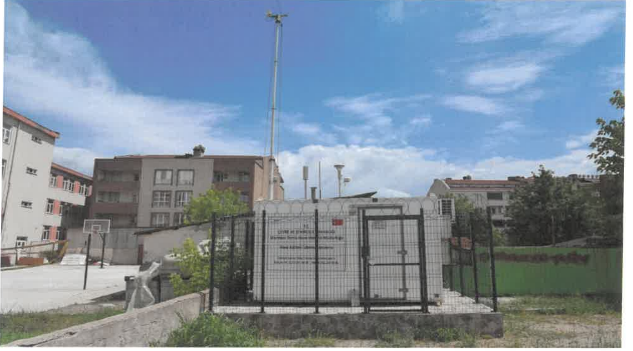
Şekil-8: Çanakkale Çan İlçesi Hava Kalitesi İzleme İstasyonu
