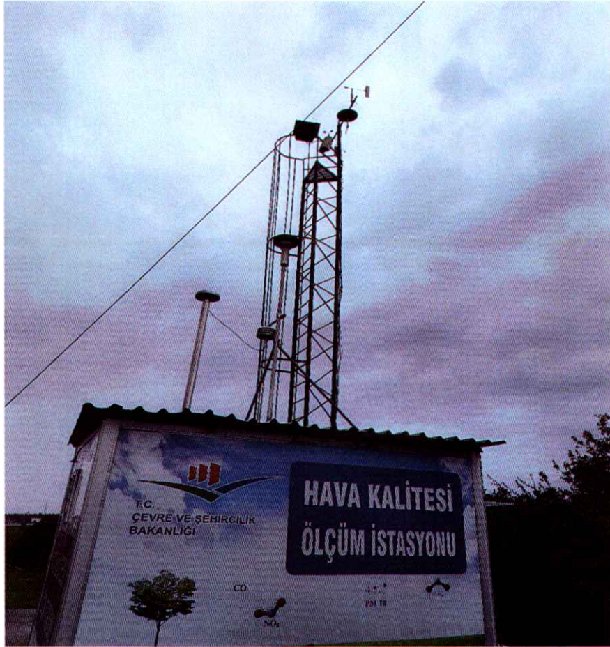
Şekil 16- Çanakkale İÇDAŞ Hava Kalitesi İzleme İstasyonu
