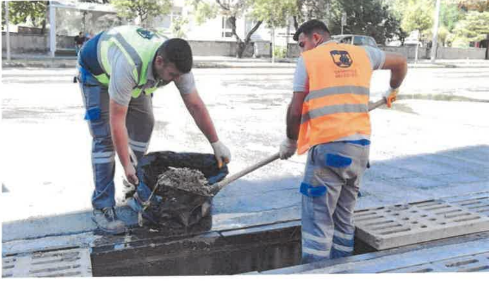
Şekil 25 Çanakkale İli yürüyüş yolunda yapılan temizlik çalışması
