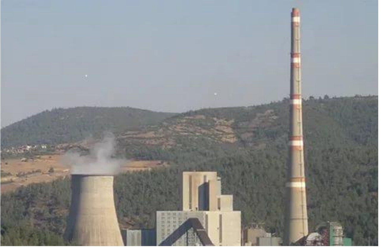
Şekil 35:Orhaneli Termik Santrali
