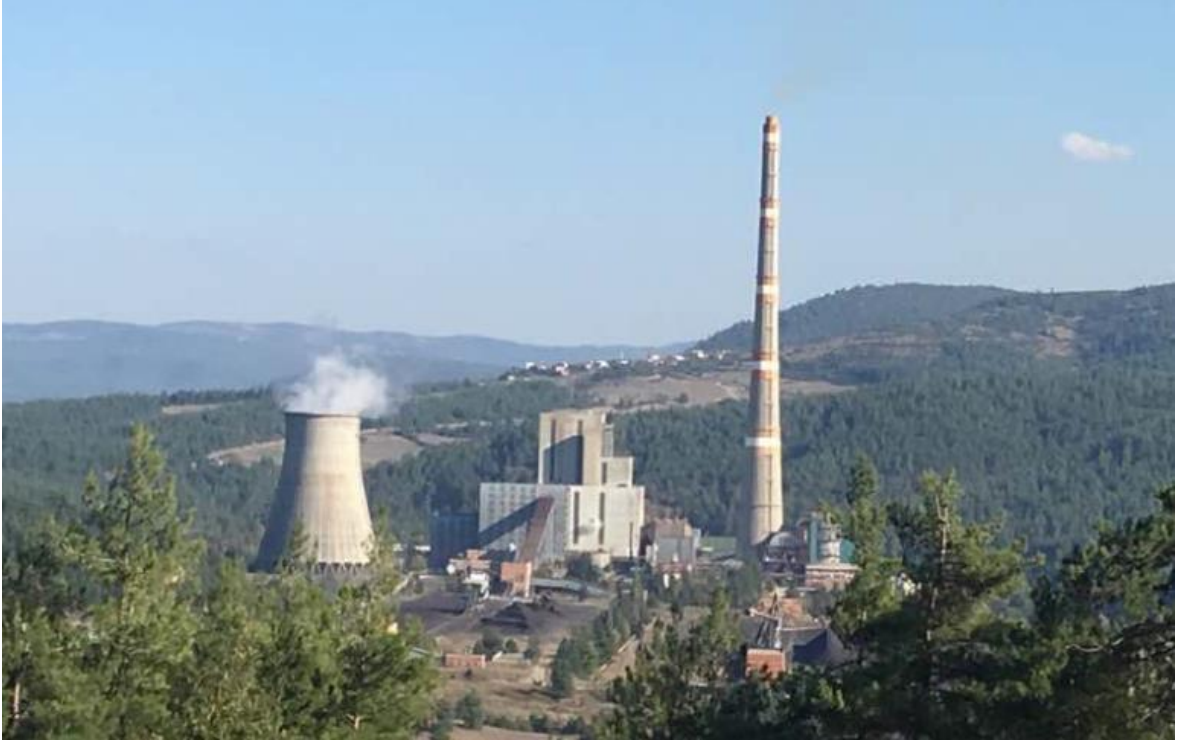
Resim C.1 – Çelikler Orhaneli Termik Santrali (BÇŞİM, 2017)
