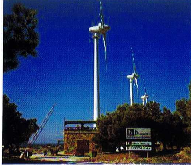
Şekil 4. Bozcaada'da Yap-İşlet-Devret (YİD) statüsündeki Enercon Türbinlerinden oluşan santrallerden bir görünüm
