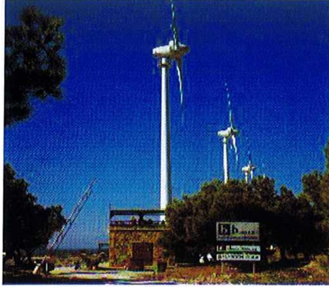
Şekil 4. Bozcaada'da Yap-İşlet-Devret (YİD) statüdeki Enercon Türbinlerinden oluşan santrallerden bir görünüm
