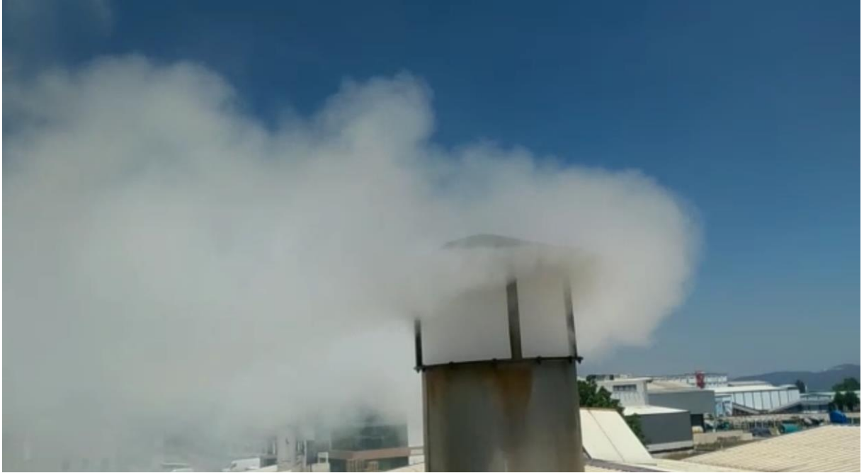
Şekil 42:Ön Fikse Bacası Filtre Öncesi Görüntüsü
