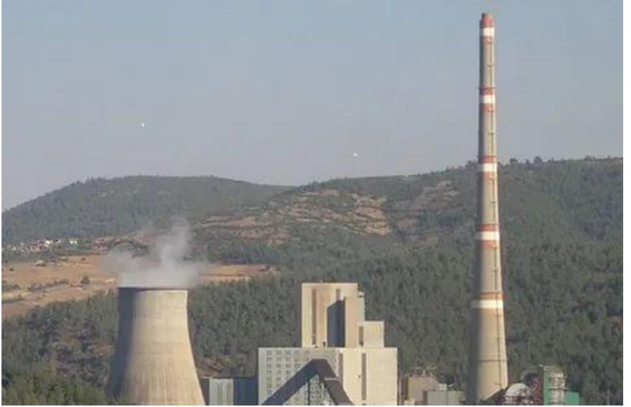
Şekil 35:Orhaneli Termik Santrali
