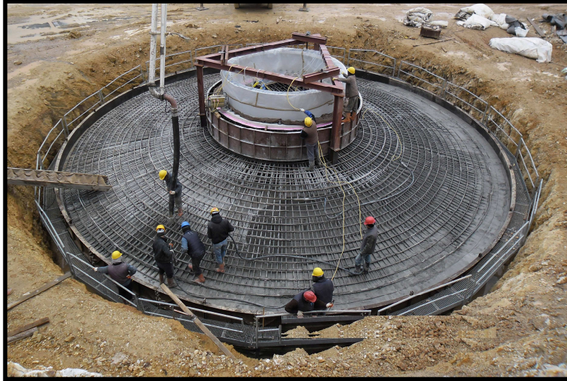
Resim 13: Türbin Temel Görünümü
