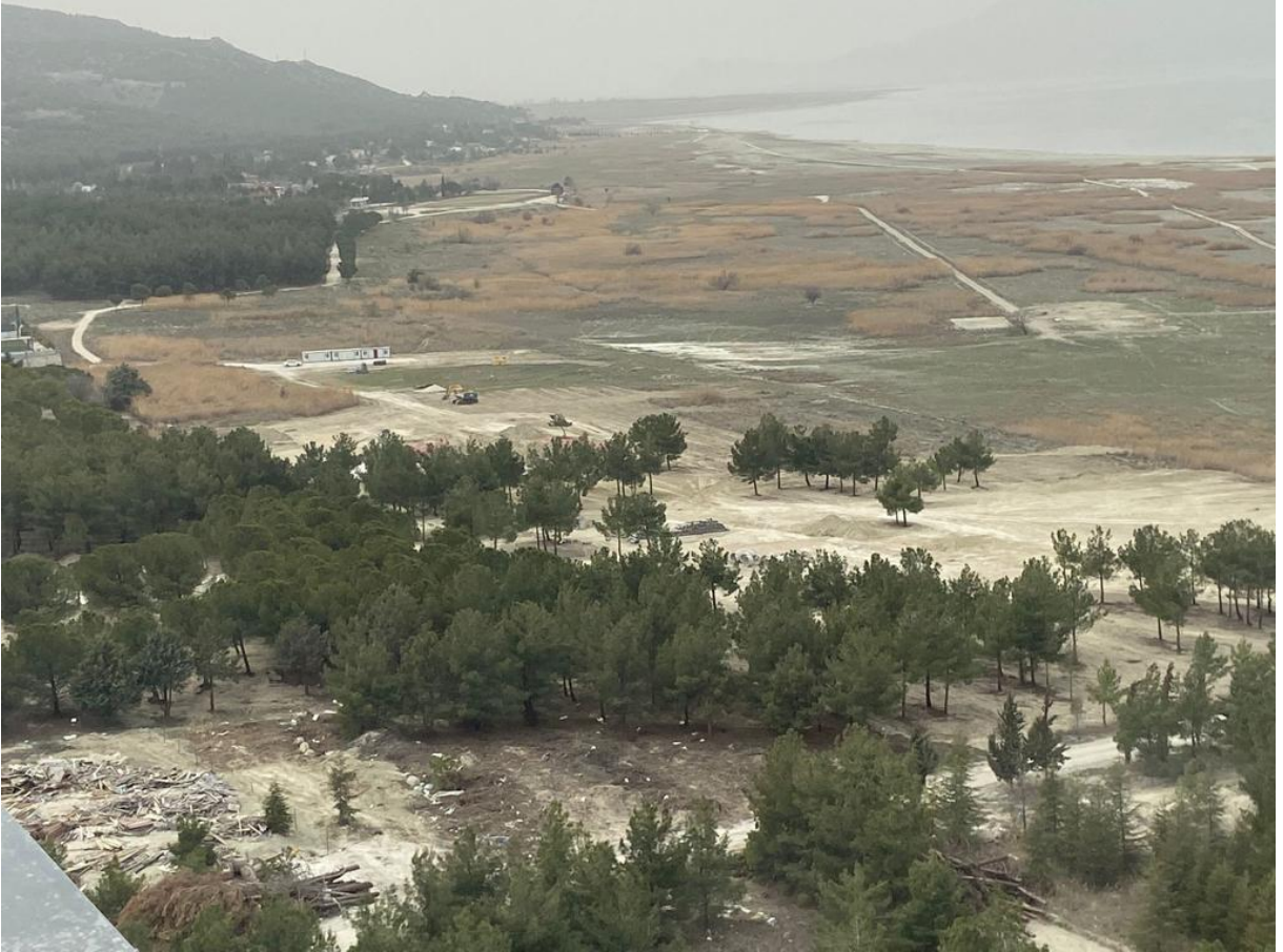
Fotoğraf 3: Planlama Alanı Kuzeydoğu Kesimlerinden Güneybatı Yönüne Bakış
