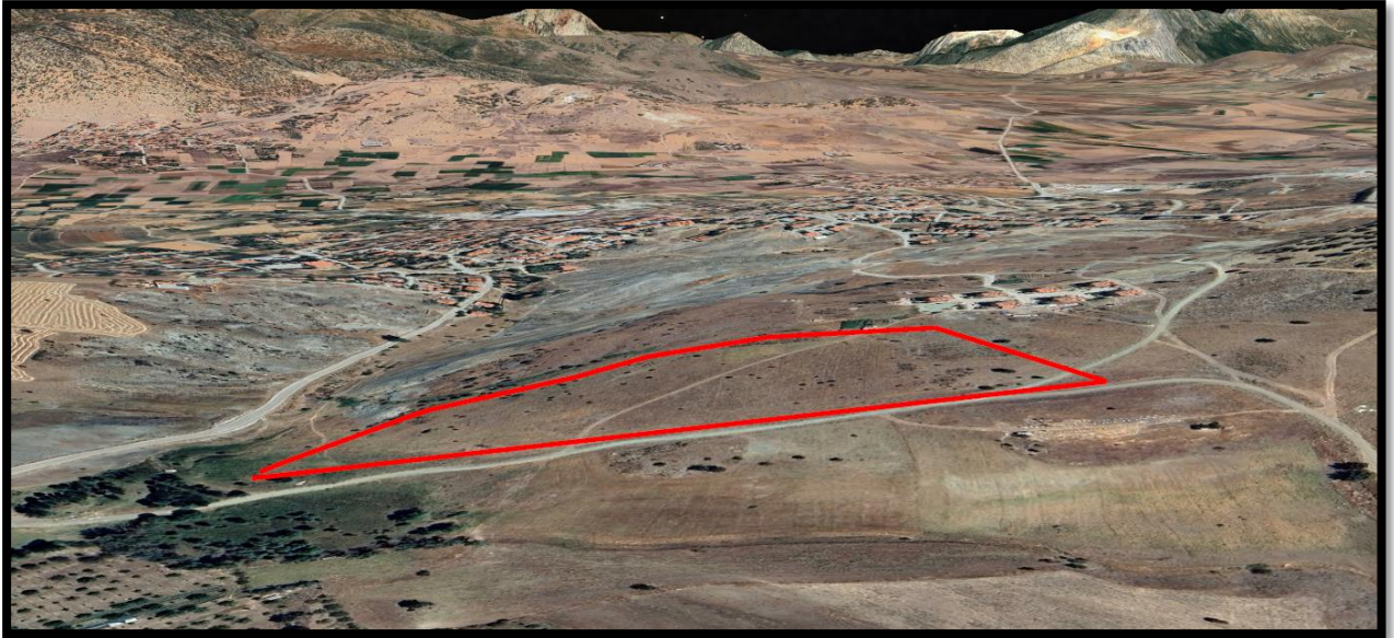
Şekil 24: Arazi Yapısı (Emek Mahallesi)
